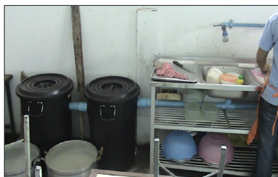
รูปที่ ๓.๑๐ ตำแหน่งการติดตั้งถังหรือบ่อดักไขมัน
