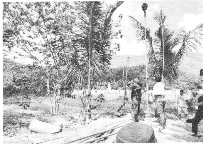
โครงการขุดเจาะบ่อบาดาลพร้อมติดตั้งเครื่องสูบน้ำแบบไฟฟ้า บ้านโคกใหญ่ หมู่ที่ ๑ ประจำปีงบประมาณ พ.ศ. ๒๕๖๖
